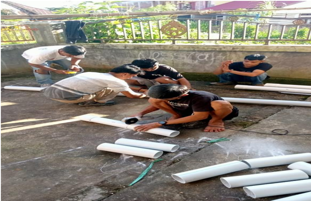
Gambar L. 13 Pematongan Pipa PVC
