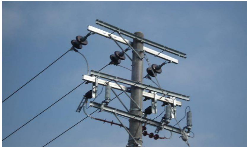
Gambar 2. 2 Jaringan Distribusi Tegangan Menengah Sumber : ( www.dutaparateknusantara.co.id/2020/06/23 )
