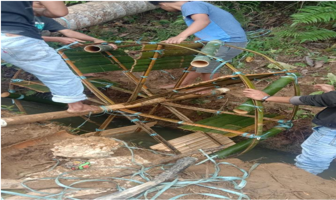
Gambar L.3. Pemasangan 8 sudu plat bambu pada roda air
