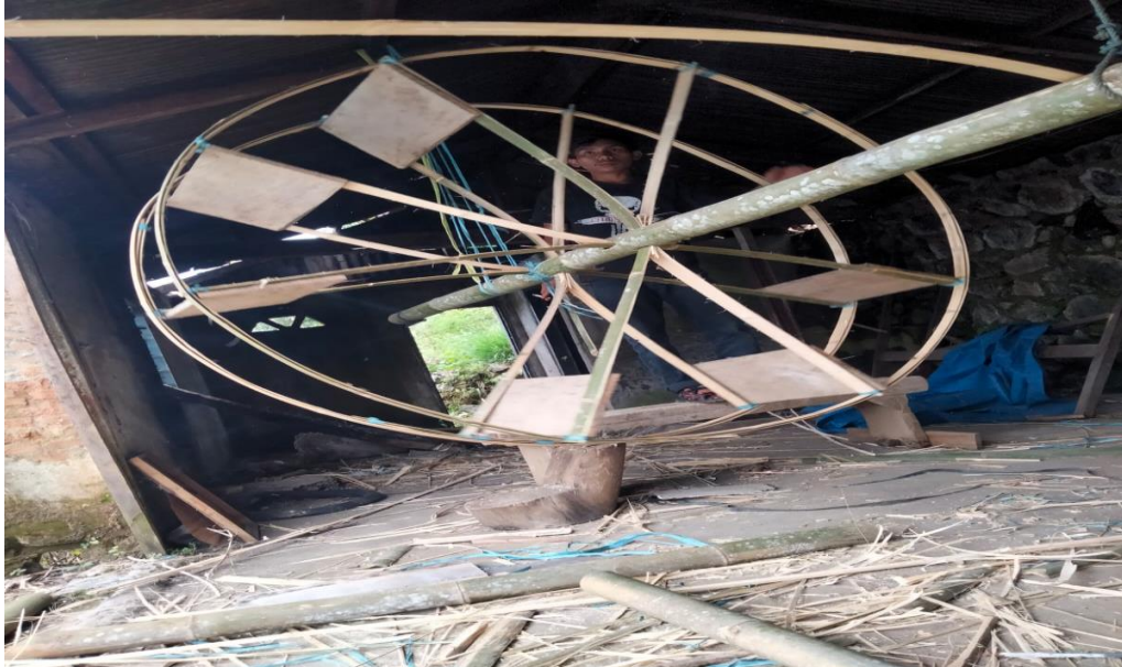
Gambar L.2. Pemasangan 8 sudu plat papan pada roda air
