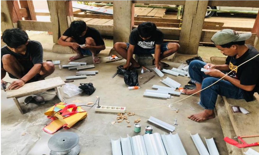
Gambar L. 18 Pemasangan sudu dan sirip
