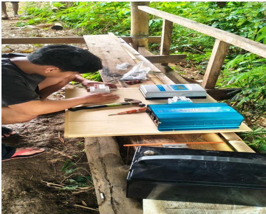
Lampiran 1. Proses pemasangan alat
