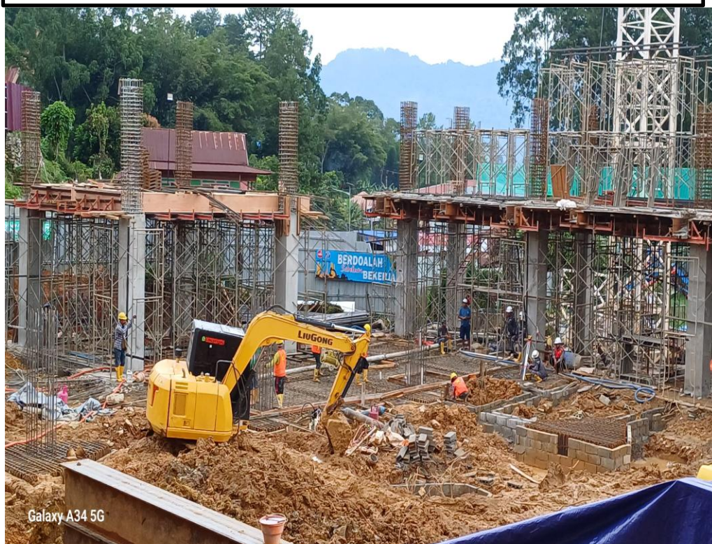
Kondisi saat ini Proyek RSUD Pongtiku Toraja Utara
