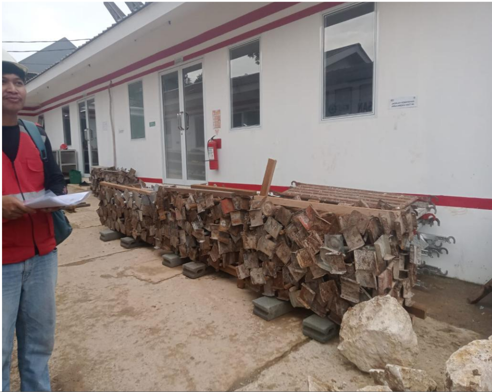
Gudang Proyek RSUD Pongtiku Toraja Utara
