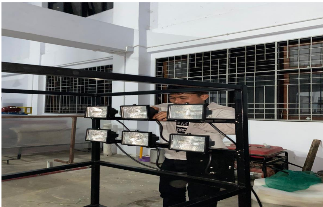
Gambar L-. 6 Pemasangan lampu hologen
