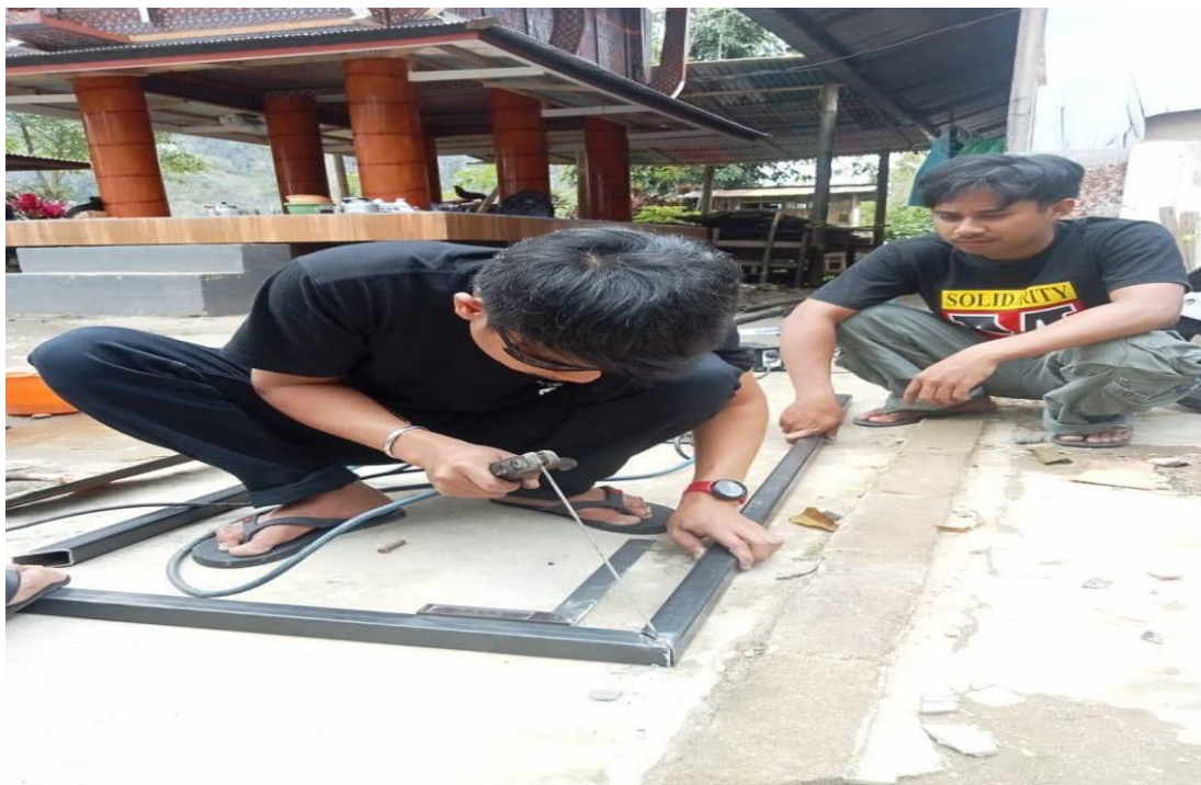
Gambar L-. 2 Proses pengalasan kerangka instalasi
