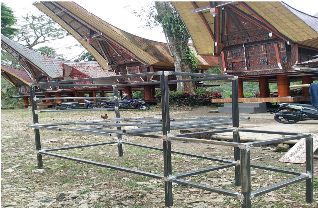
Gambar L-. 3 Instalasi kerangka solar cell
