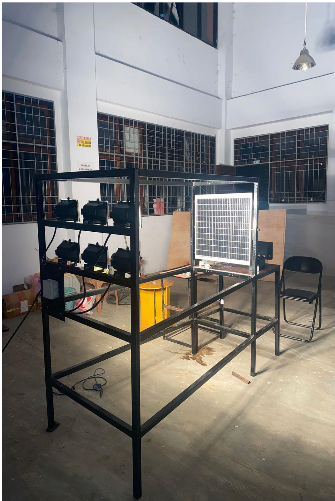
Gambar L-.10 Instalasi solar cell tampak belakang
