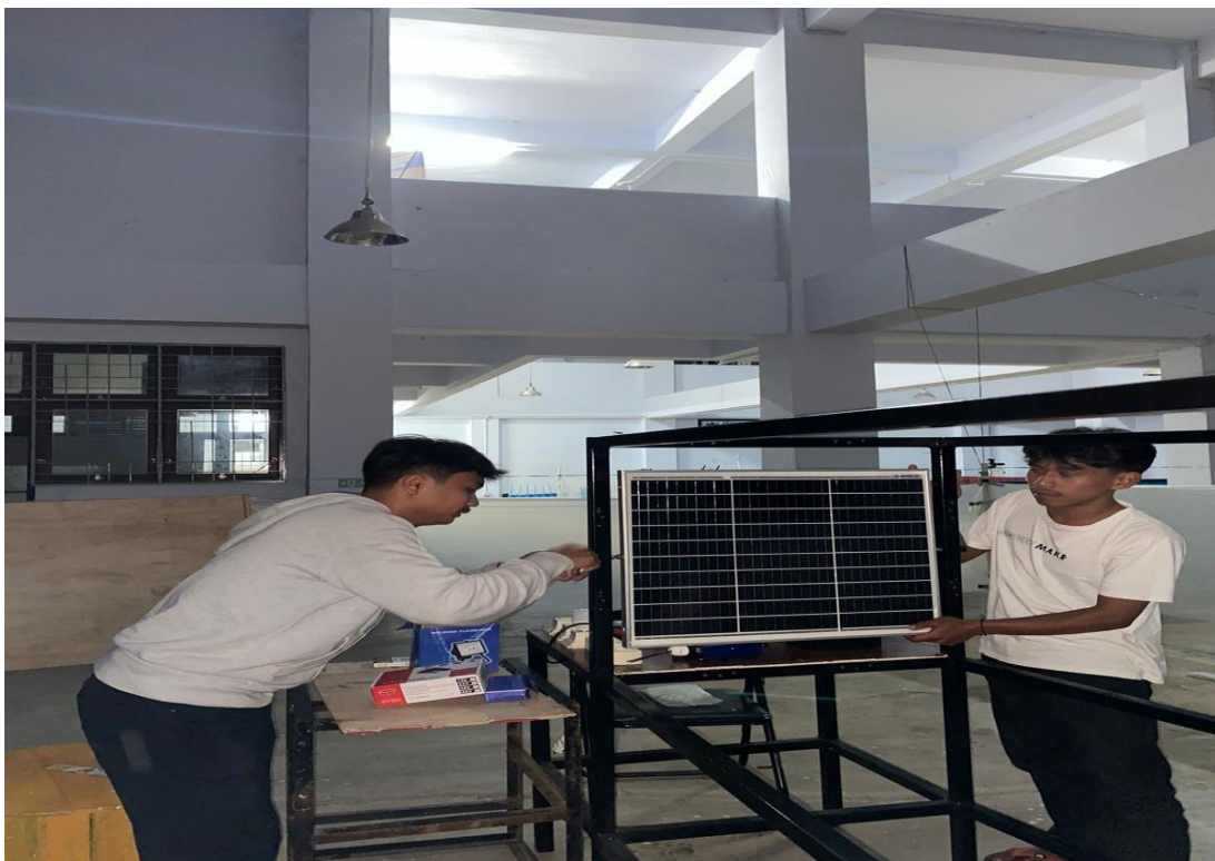
Gambar L-. 4 Pemasangan solar cell tipe polycrystalline
