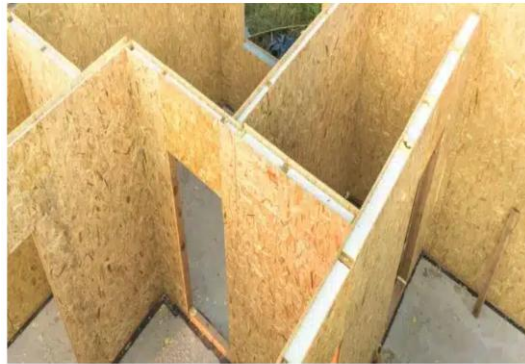
Gambar 2. 5 Dinding panel semasa proses konstruksi
