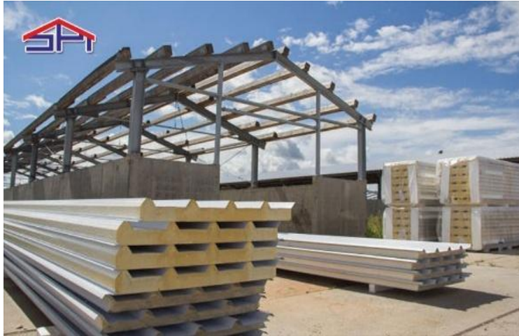
Gambar 2. 7 Penggunaan dinding panel di Kawasan industri
