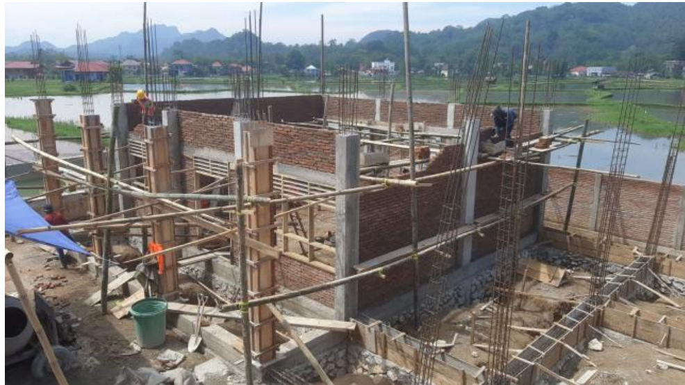
Gambar pemasangan batu bata
