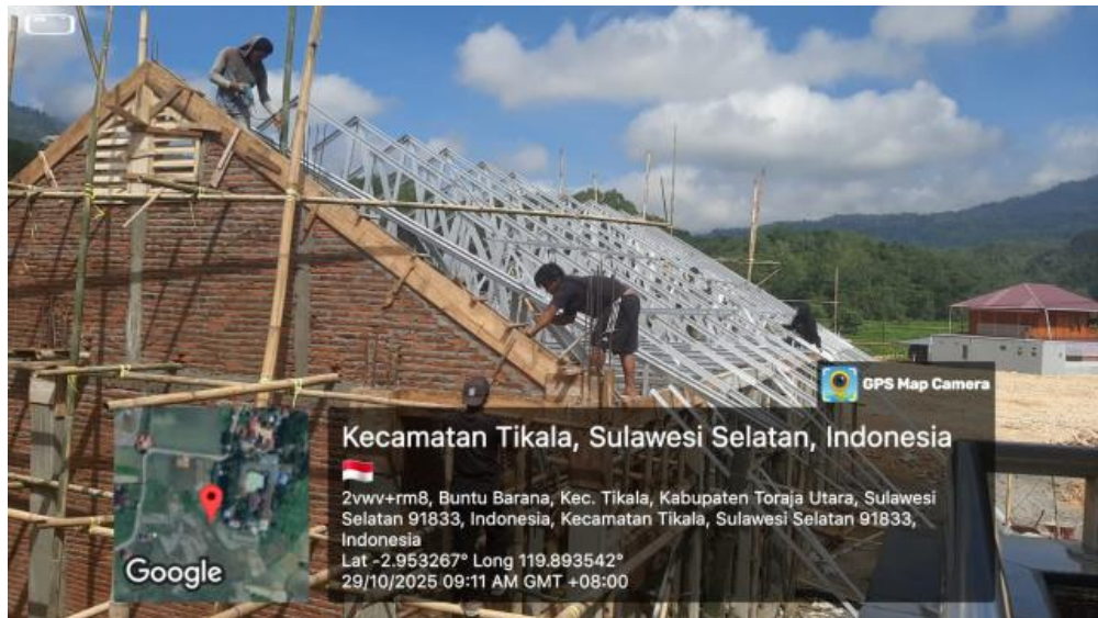
Gambar pemasangan rangka atap baja ringan
