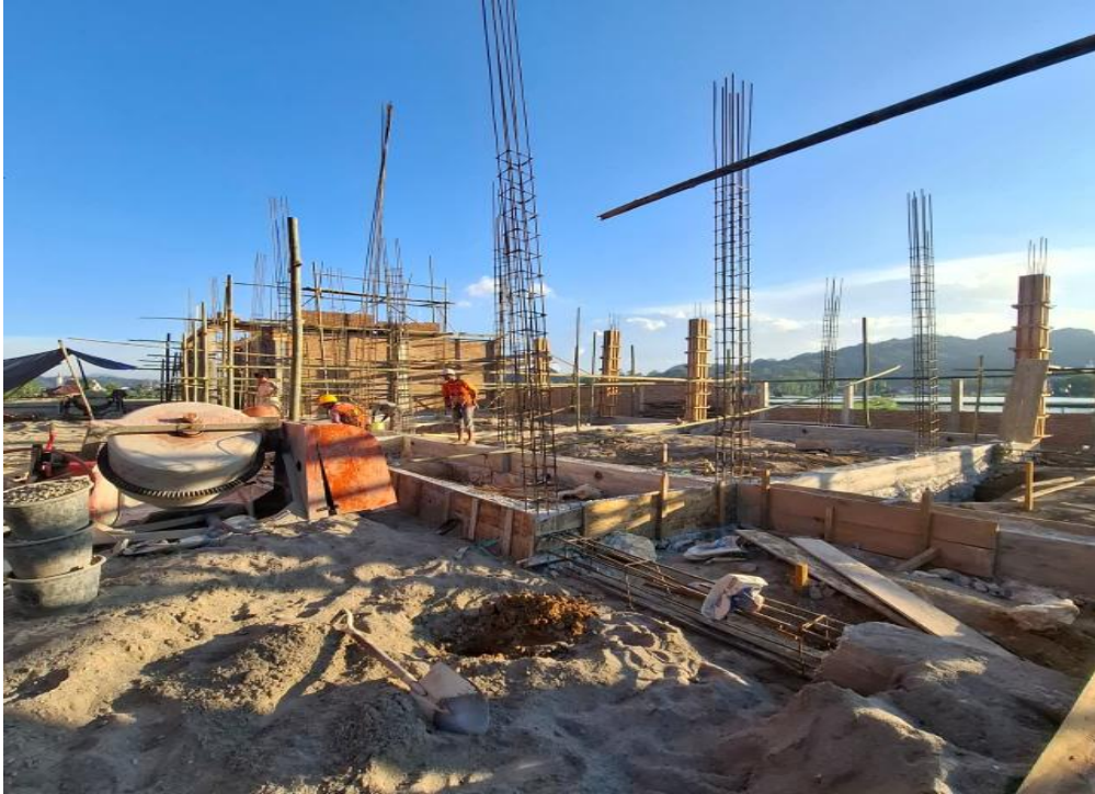
Gambar pemasangan tiang
