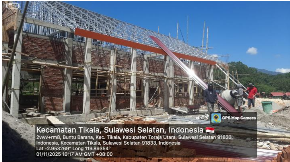
Gambar pemasangan atap spandek
