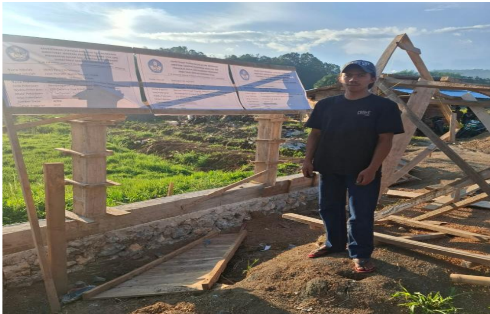
Gambar survey lokasi
