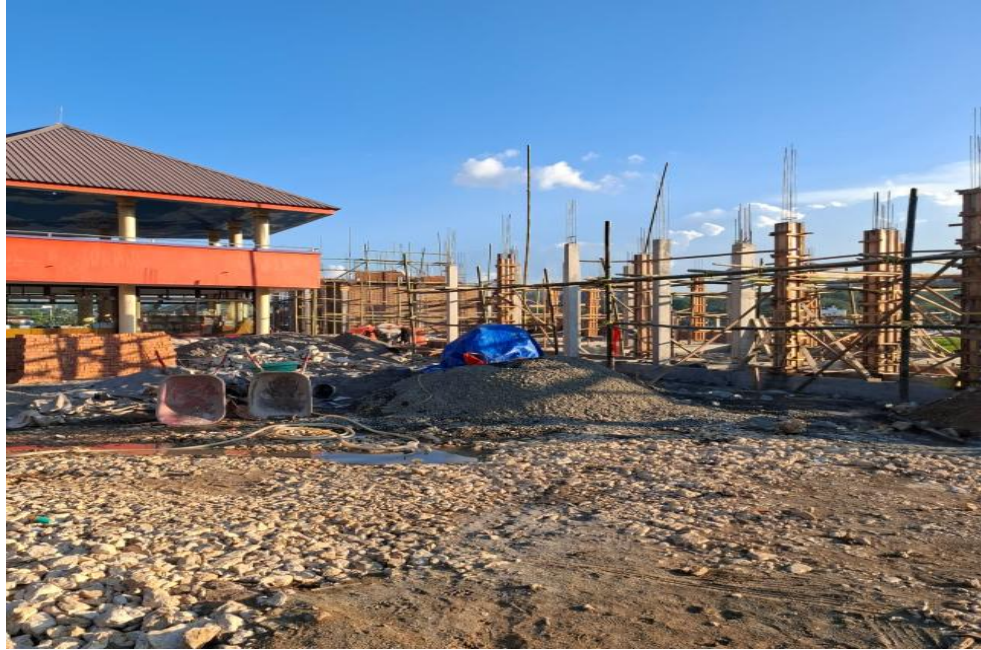
Gambar pelepasan bekisting pada tiang
