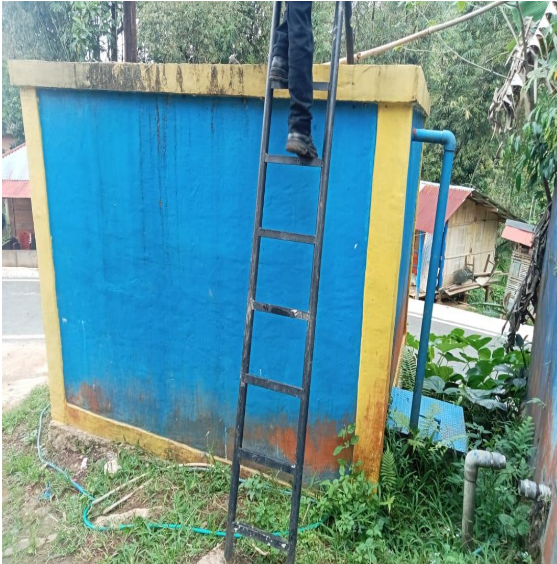
Kondisi Bak Penampung Air
