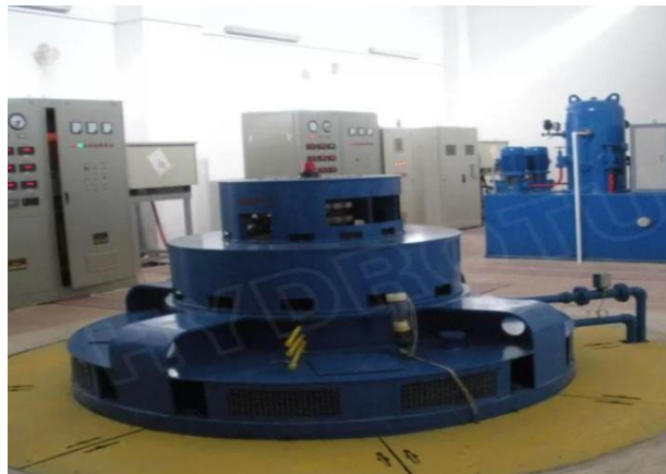
Gambar 2.5 Turbin Kaplan Sumber: (Syariet, R 2015)
