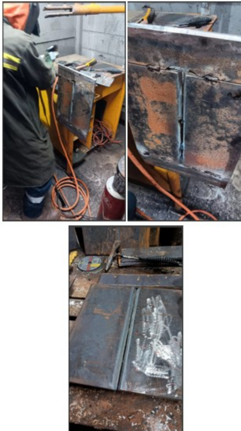
Persiapan flat baja untuk pembuatan kampuh V ( V-groove plate preparations process ).
