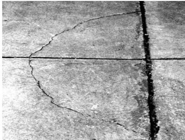
Gambar 2.3. Kerusakan Corner Break
