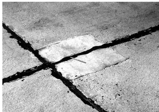
Gambar 2.11. Kerusakan Patching Small
