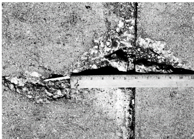
Gambar 2.19. Kerusakan Spalling Corner
