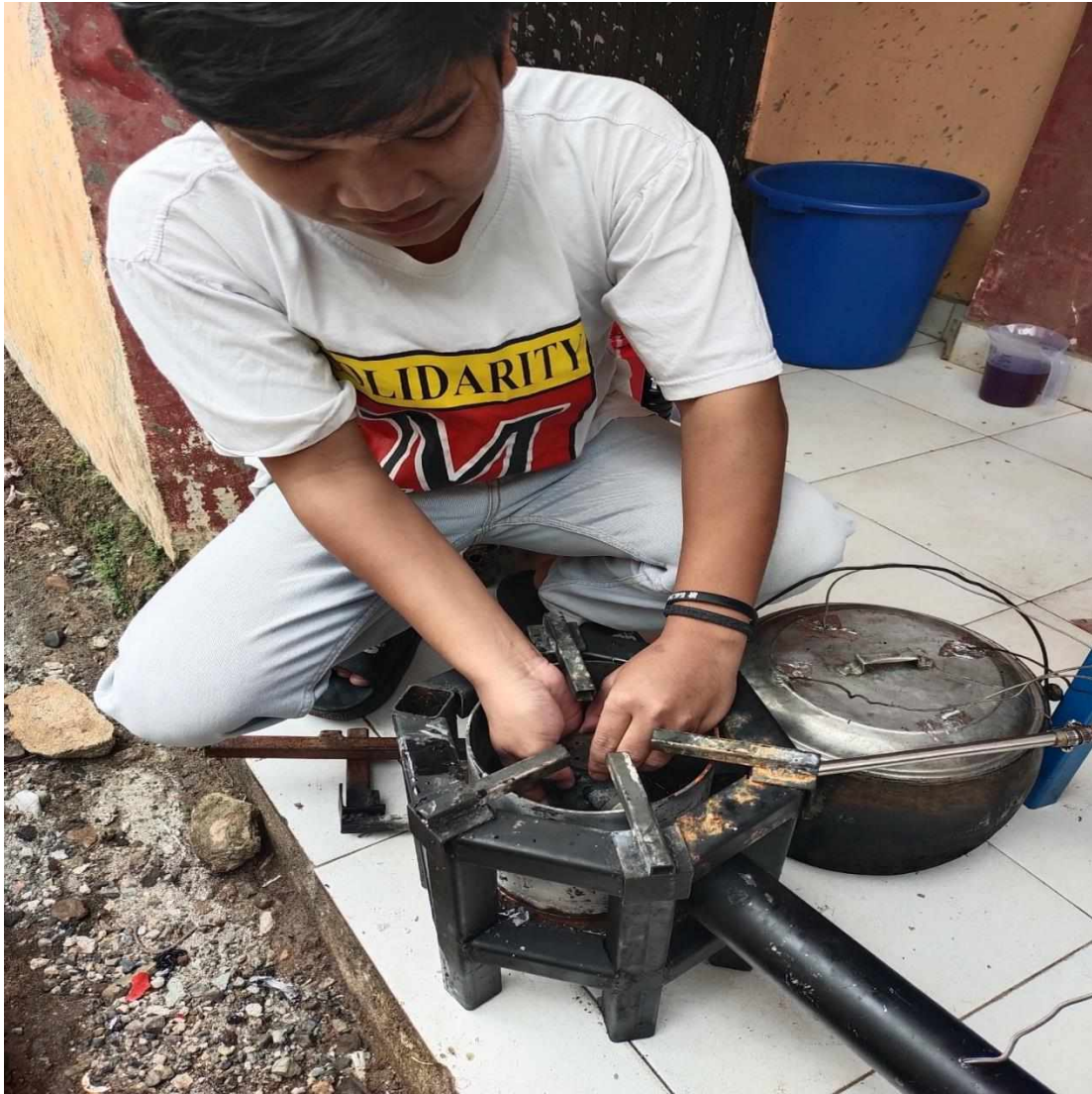
Gambar L.11 Dokumentasi pemasangan Nozzle burner kedalam tungku
