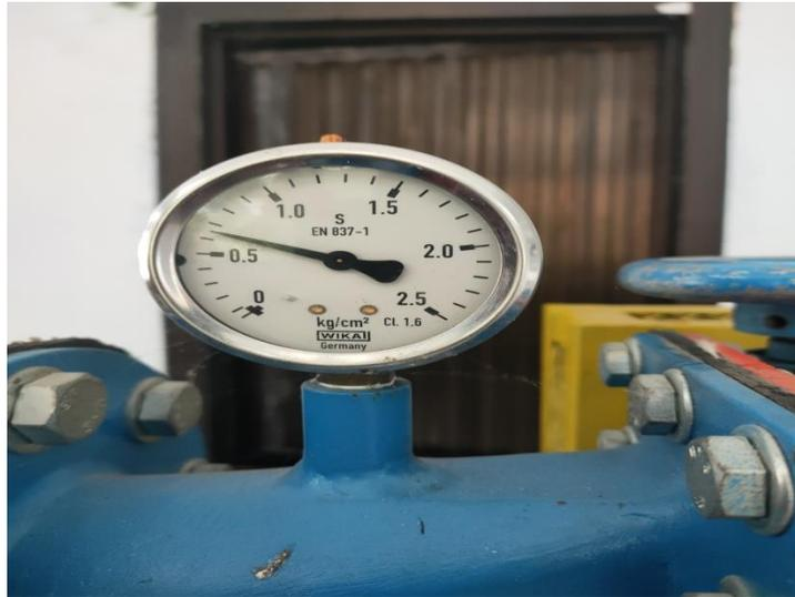
Gambar 1. Alat ukur tekanan air pada turbin
