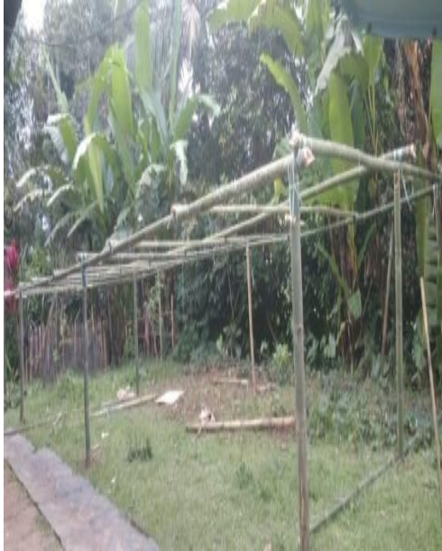
Gambar 2. Sanitasi dan pemasangan Tiang
