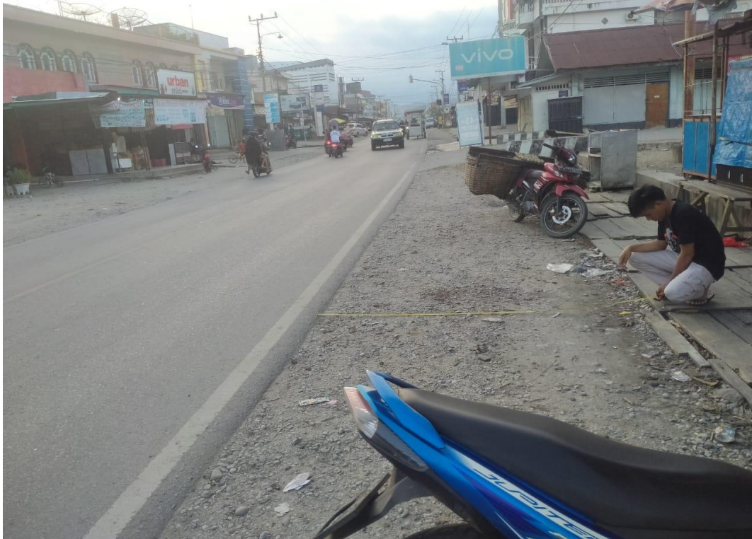
Gambar E.1. 1 Pengukuran Lebar Bahu Jalan
