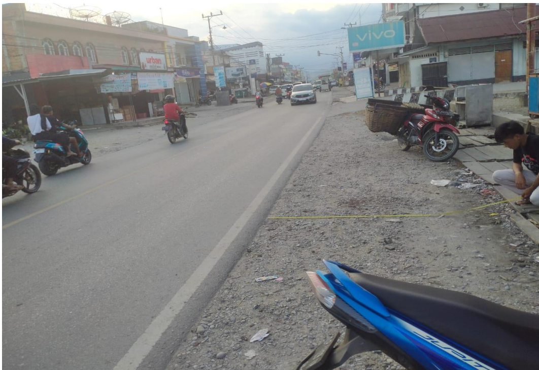
Gambar E.1. 2 Pengukuran Lebar Bahu Jalan
