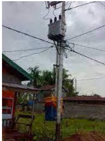
Gambar 2.4 Konstruksi Gardu Cantol
