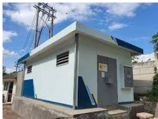
Gambar 2.3 Konstruksi Gardu Beton
