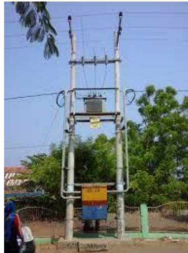
Gambar 2.5 Konstruksi Gardu Portal
