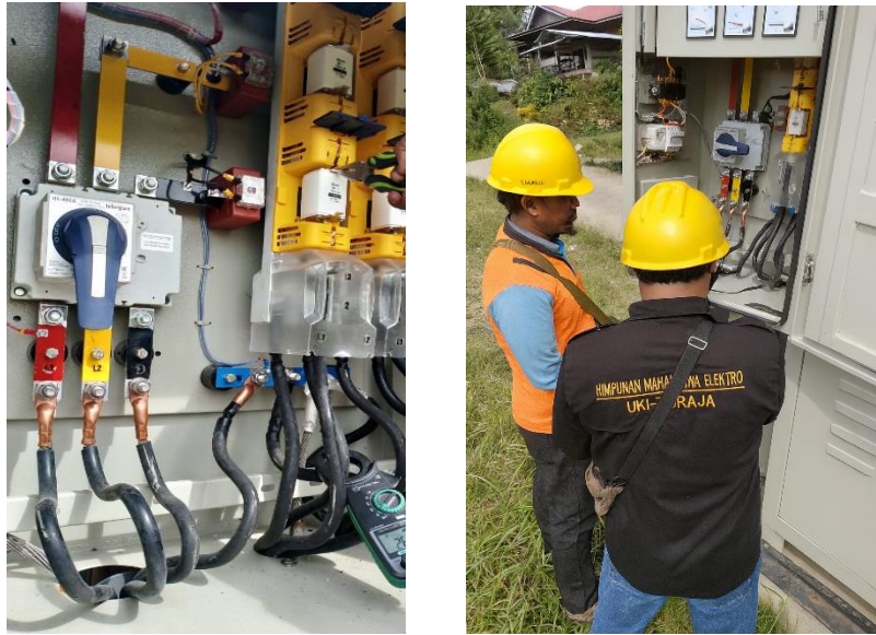
Gambar 2.2 Bagian Dalam Gardu Distribusi
