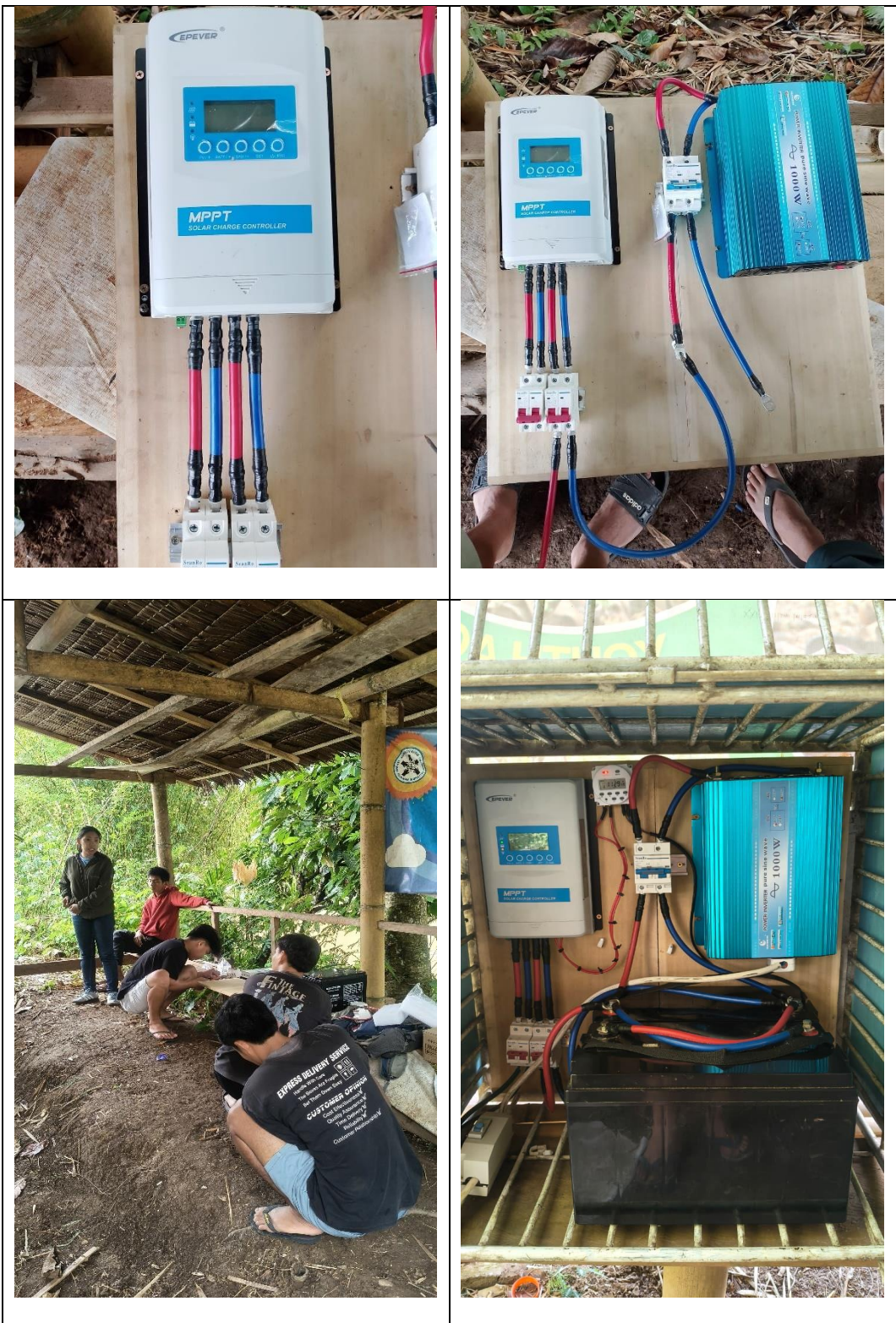
Tahap perakitan sistem PLTS
