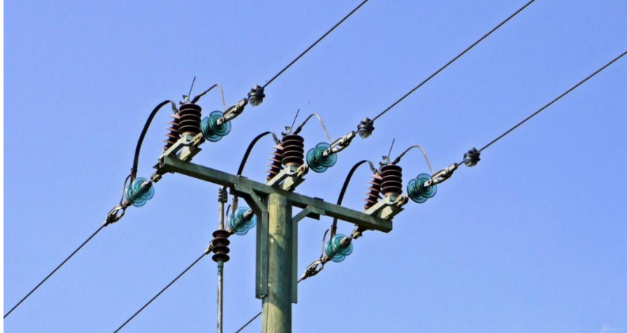
Gambar 2. 3 Jaringan Tegangan Menengah (JTM)
