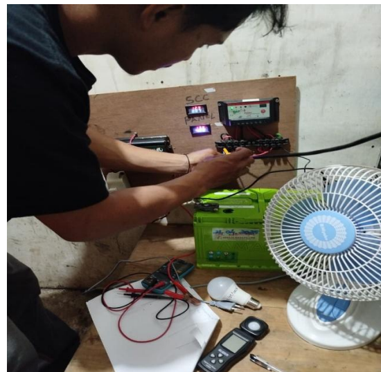
Gambar 1.6 Proses pemasangan alat
