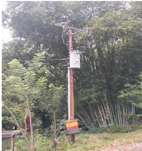
Gambar. Gardu GD 680 IE Sebelum Perluasan Jaringan Tegangan Rendah (JTR)
