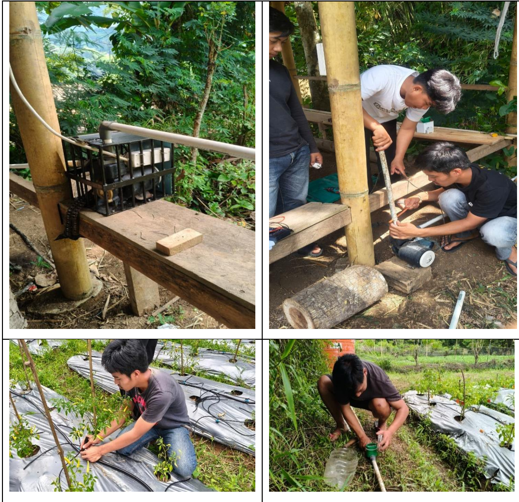
Pemasangan pompa air dan instalasi penyiraman
