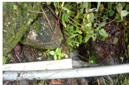
Pipa dari mata air ke Bak resevoir
