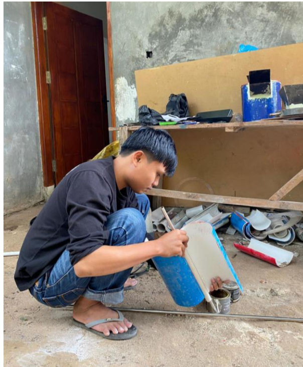
Gambar L.14 Proses Pemasangan Sudu
