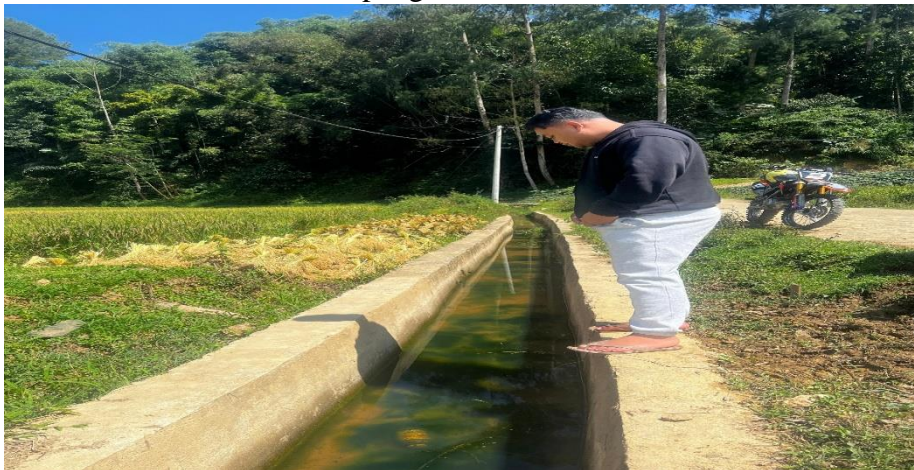
Dokumentasi keadaan dinding saluran irigasi
