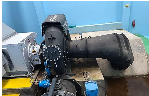
Gambar 2.2 Turbin Air Tipe Francis Sumber: (Dokumentasi Pribadi, 2024)
