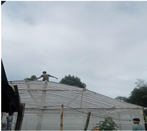
Gambar 9. Perbaikan Green House dan Instalasi
