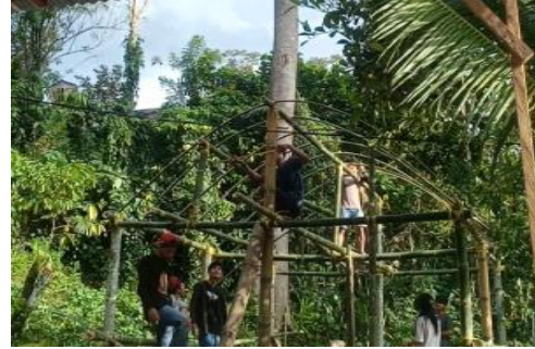
b.pembuatan rangka atap rumah tumbuh
