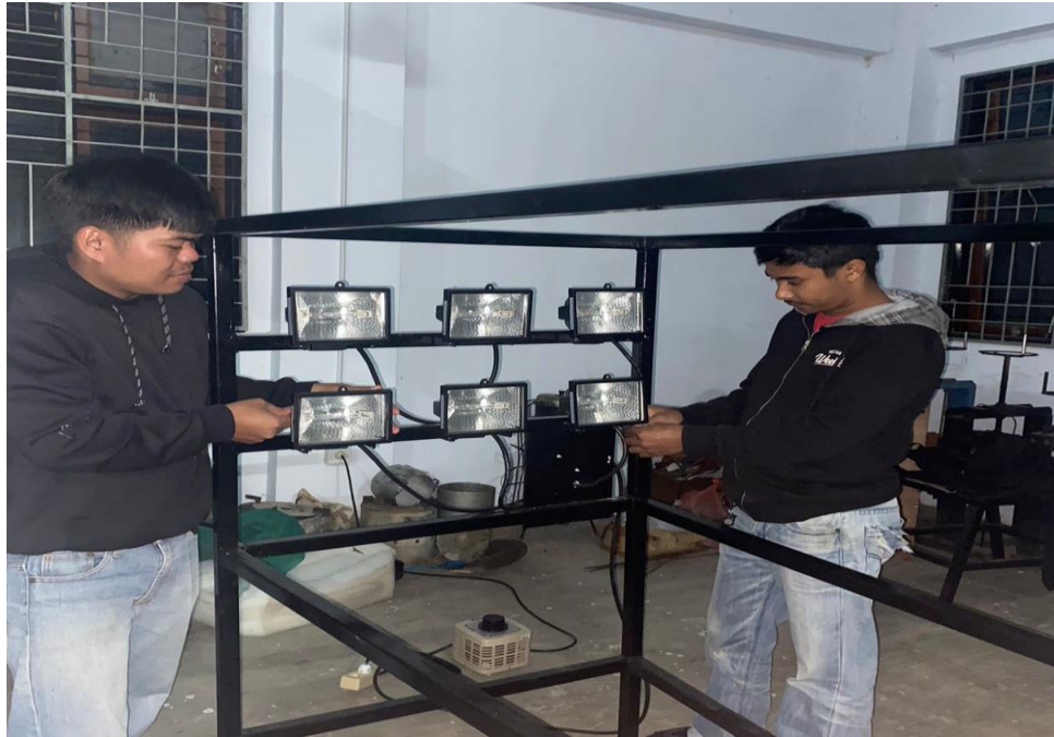
Gambar L-. 3 Pemasangan lampu hogen
