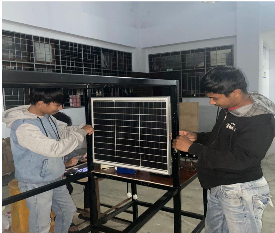
Gambar L-. 2 Pemasangan solar cell tipe Monocrystalline
