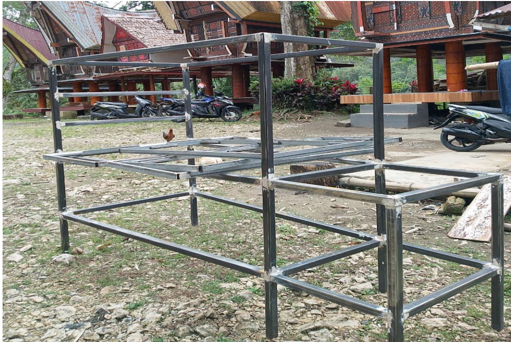
Gambar L-. 1 Instalasi kerangka solar cell
