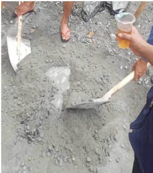
Proses pencampuran dan pengadukan material
