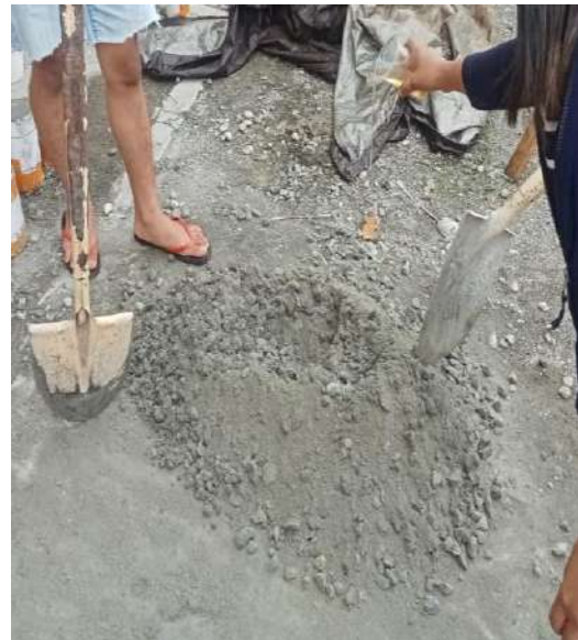
Proses pencampuran dan pengadukan material
