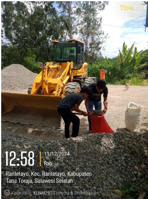
Pengambilan Material Agregat Kasar
